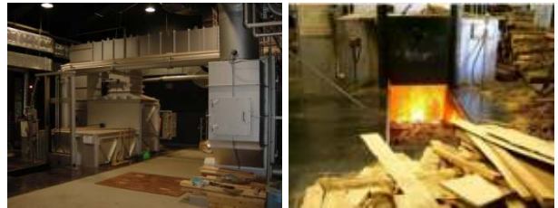
写真：「瀬音の湯」バイオマスボイラー WEBサイト「東京の森と木」
